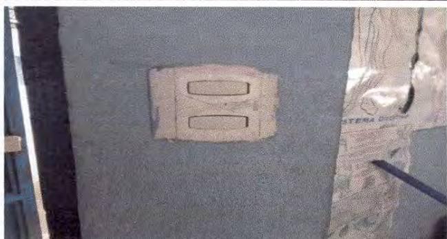
Foto 13: Sustitución de interruptores dobles
