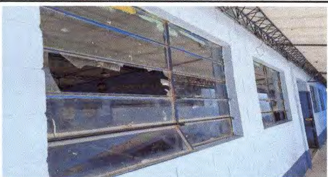
Foto 9: Sustrucion de vidrio
