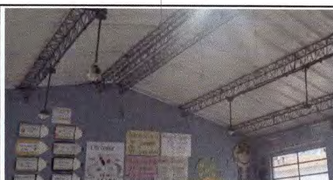
Foto 12: Sustrucion de focos ahorradores + Sustrucion de plafoneras
