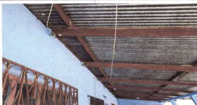
Foto 2: Mantenimiento a estructura de soporte de madera
