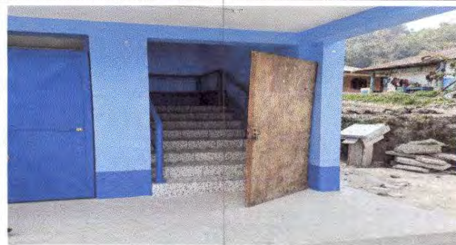
Foto 16: Fabricación e instalación de Puerta de rejas
