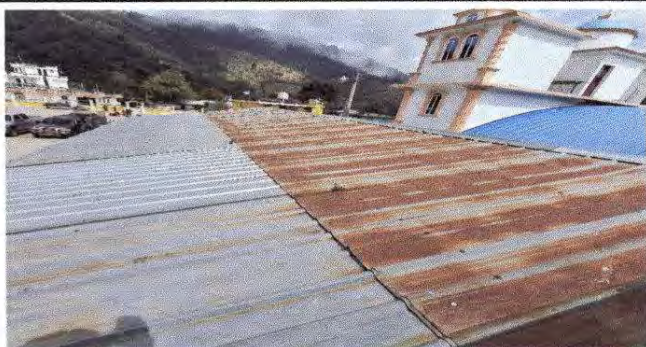
Foto 1: Sustrucción de lamina por lamina troquelada alizinc calibre 26 + Sustrucción de capote de lamina para lamina troquelada + Sustrucción de elementos de fijación
