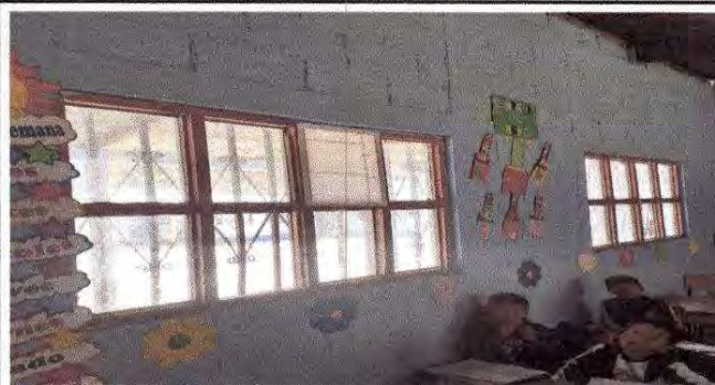
Foto 8: Mantenimiento a estructura de madera de ventana
