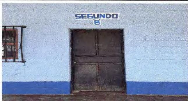
Foto 7: Sustrucion de puerta
