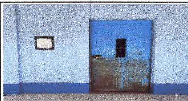
Foto 6: Sustrucción de chapa
