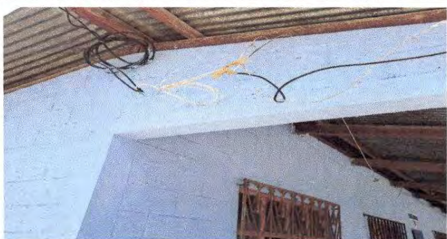
Foto 15: Reparación de cableado eléctrico + Sustitución de ducto eléctrico + accesorios
