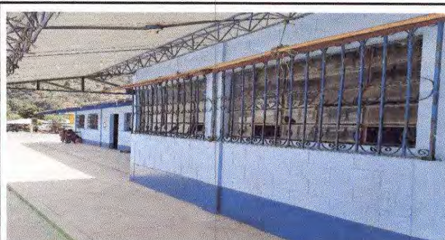
Foto 10: Mantenimiento Balcones de metal
